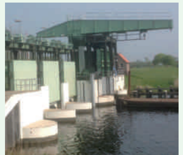
Sinds 1978 voorzien van Trimetal: de Kadoelerkeersluis bij Vollenhove.
