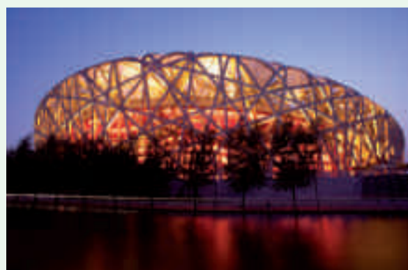
Poedercoating zijn aangebracht op de stalen constructie van het Nationaal Stadion in Peking, China. Het stadion heeft de bijnaam ‘Het Vogelnest’.
